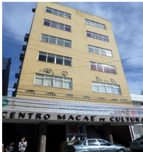
Imagem 09: Centro Cultural de Macaé. Fonte: Tainá Ferreira, 2016.
