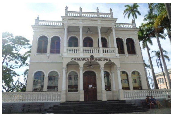
Imagem 10: Antiga Câmara Municipal de Macaé. Fonte: Tainá Ferreira, 2016.
